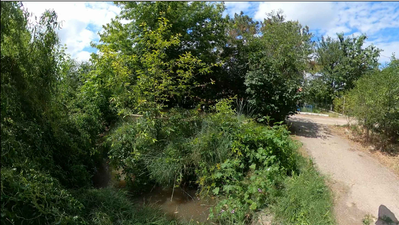
Вид на выход канализационных стоков возле подъезда дома.
