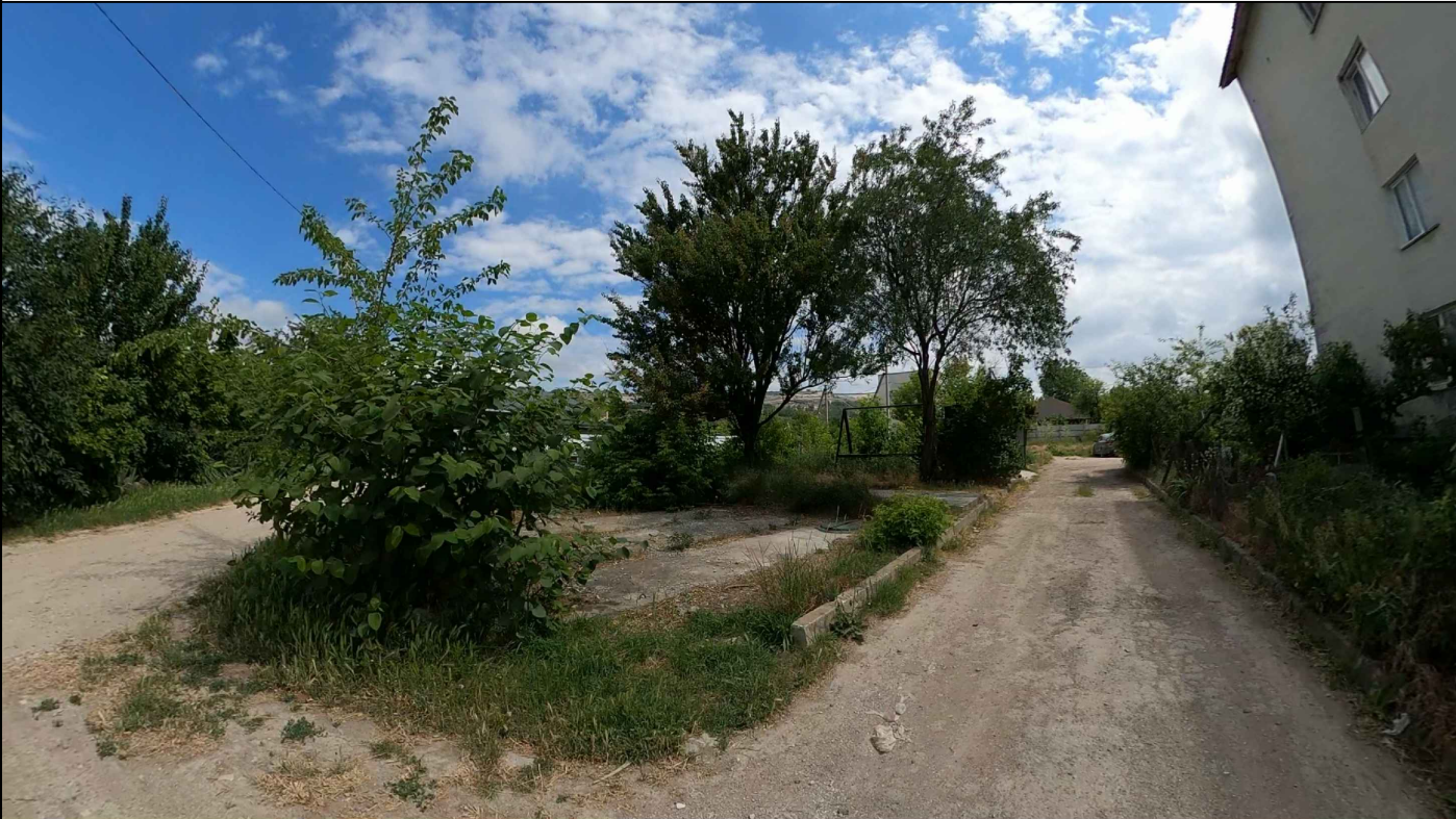
Вид на резервный накопитель канализационных стоков и место установки КНС со стороны ул. Гагарина.
